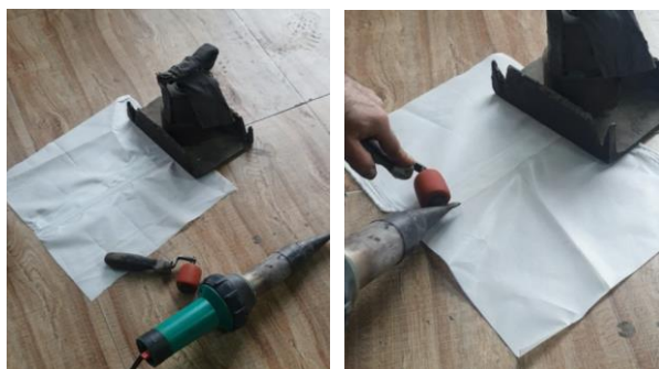
شکل ۷- اتصال پارچه توسط تجهیز جوشکاری حرارتی هوای داغ.
